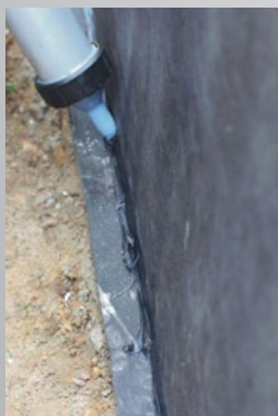
Rozłożyć membranę AlphaPro na pionową izolację ściany
