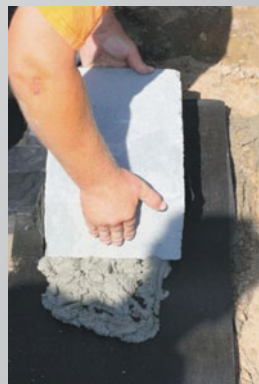
Rozpoczęcie murowania fundamentu z bloczków betonowych.
