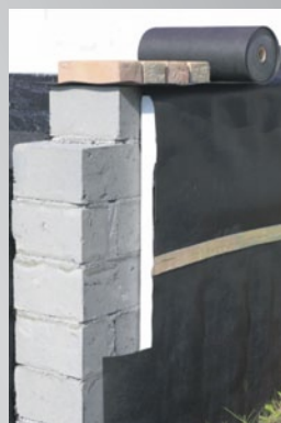
Ułożyć górną warstwę membrany AlphaPro na izolację poziomą.
