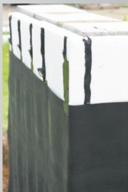
Rozłożyć membranę AlphaPro na pionową izolację ściany
