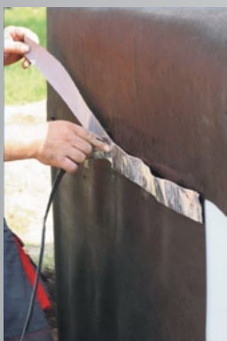
Połączenia membran AlphaPro uszczelnić taśmą AluBut.
