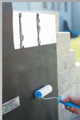
Dokładnie docisnąć w łączeniach membrany AlphaPro z klejem MS Polimer.
