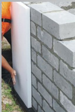
Na mur lub płytę izolacyjną za pomocą wyciskacza nanieść klej MS Polimer TECFIX441w pozycji pionowej w celu zapewnienia cyrkulacji powietrza.
