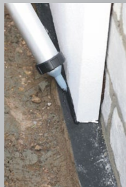
Starannie zabezpieczyć klejem w miejscu styku z poziomą izolacją.
