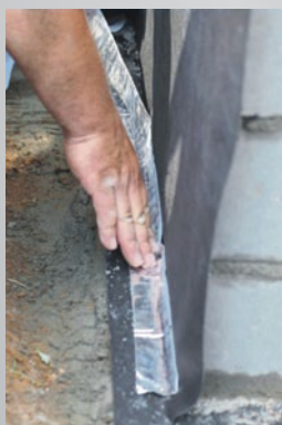
Połączenia membran AlphaPro uszczelnić taśmą AluBut.
